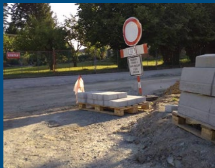
Rekonstrukcí prochází i ulice Krátká a Lesní. Získají nový asfalt a odvodnění.
