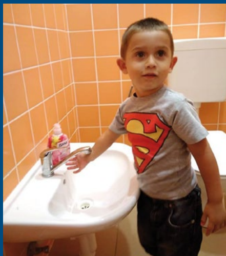
Mateřská školka má nové umyvadlo pro nejmladší děti. S jeho instalací bylo nutné zároveň předělat odpad a přívod vody.
