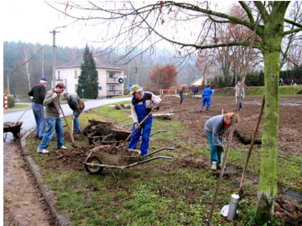
Základní práci na obnově Paškova parku v roce 2013
