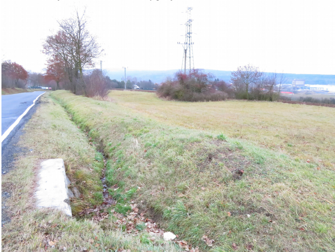
Pohled směrem k Dýšině – propustek, příkop s tekoucí vodou od křížku a z dalších příkopů, louka.
